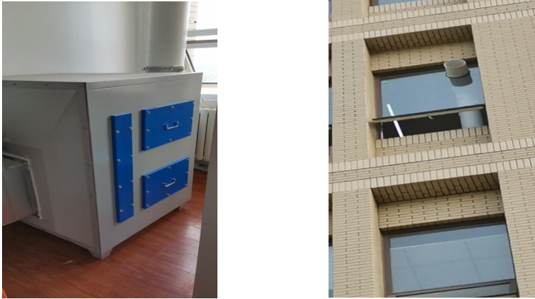
图5 项目废气治理设备照片、废气排口照片
